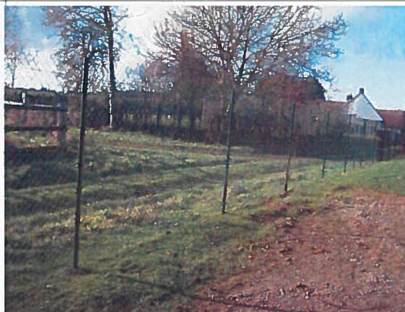
5 : clôture remplacée le long de la vc n°126 au sud-ouest
