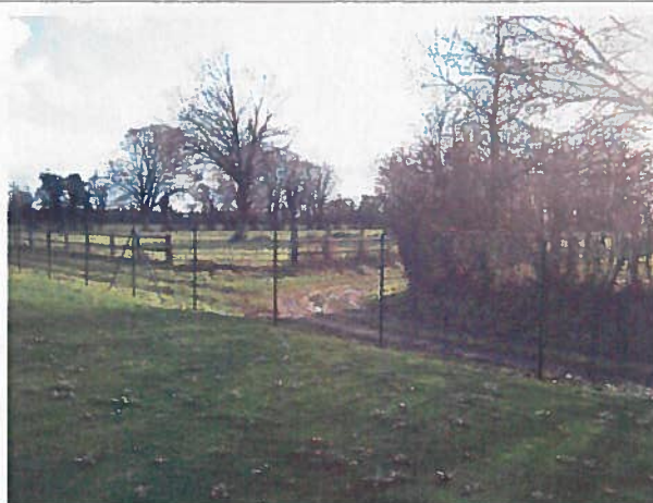
4 : clôture remplacée le long de la vc n°126 au sud-est
